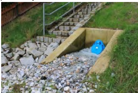
Obr. 10 Výústní objekt do rybníka, celková situace a detailní pohled na výúst s žabí klapkou (zdroj: archiv SVSMP)
